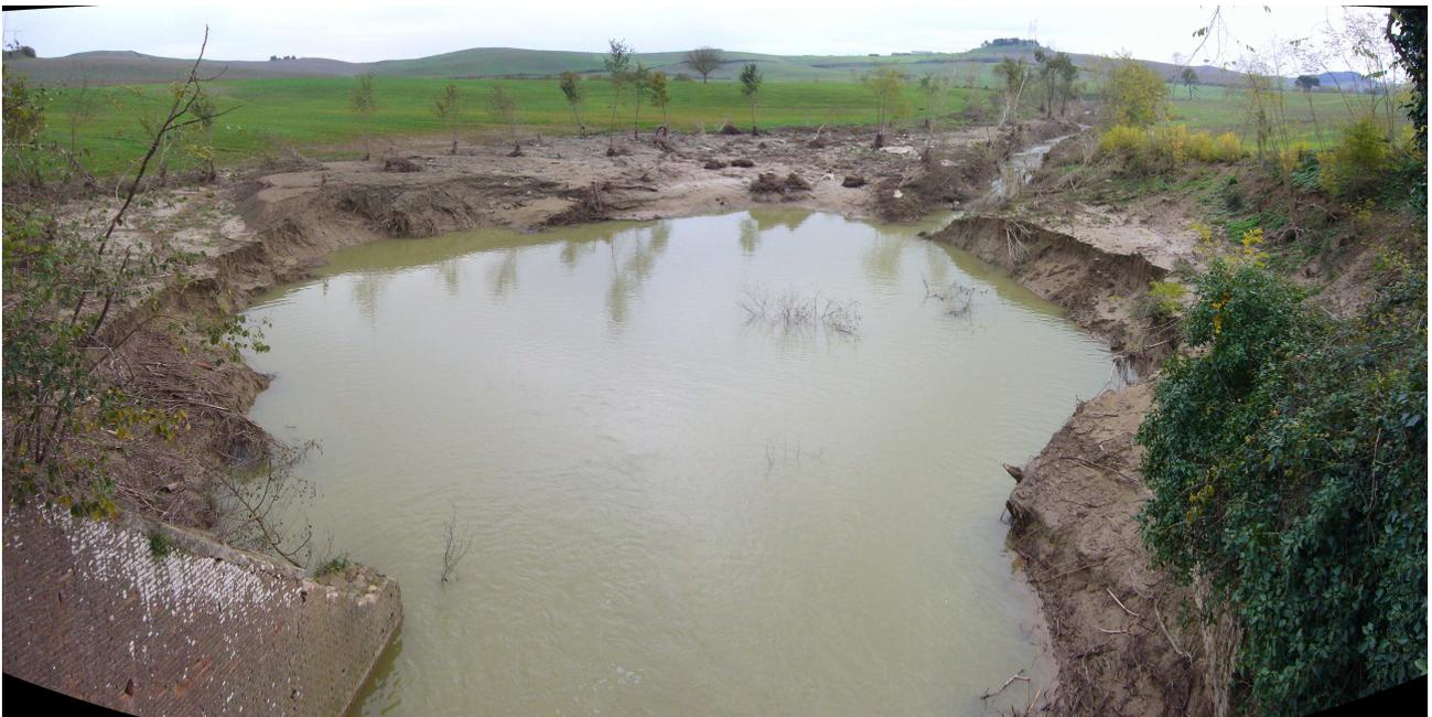
**Foto 2. Il torrente Sorra al ponte presso la loc. Radi nel novembre 2013, dopo gli eventi alluvionali di ottobre 2013 che ebbero pesanti effetti sulla stabilità degli argini, completamente messi a nudo da un esteso intervento di taglio della vegetazione riparia effettuato a fine estate.**
